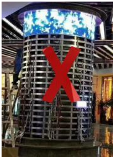
禁止镀锌方管结构安装
